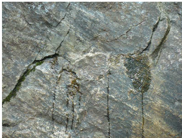
Photographie illustrant la circulation des eaux souterraines dans les roches cristallophylliennes (zones de fissuration et de fracturation = zones de circulation)
